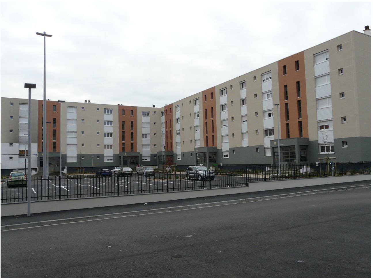
Plaine d'Ozon - Réhabilitation
