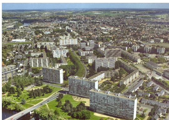
Le site avant les opérations
